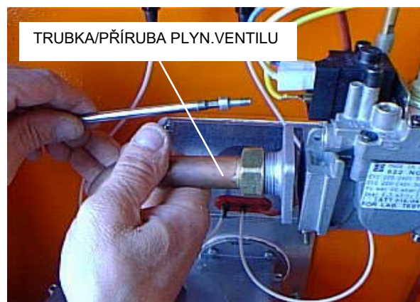
Obrázek 38 - trubka/příruba plyn.ventilu
